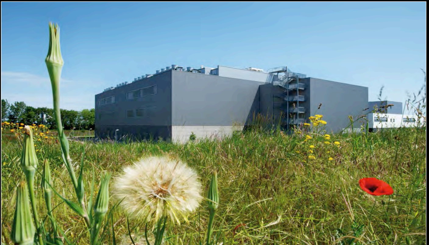
Photo: Deutsche Telekom
